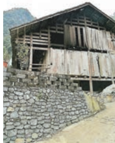
吳秀文家的老房子成了村裡最後幾座竹木結構干欄式吊腳樓建築。
