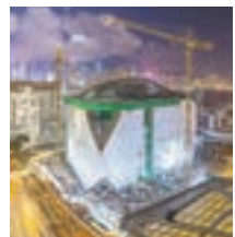
建設中的西九戲曲中心。(西九文化區管理局提供)
