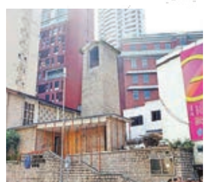
拆除前的佑寧堂全貌。資料圖片
