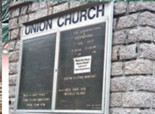
貼有通知板的佑寧堂牆身，石頭排列盡顯戰後風貌。
