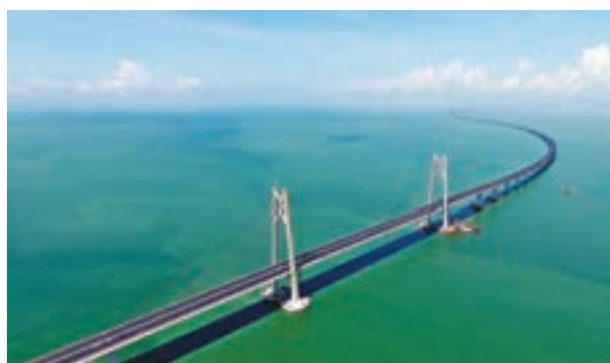
港珠澳大橋完善了珠三角區域的陸路交通連接。
