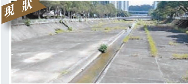
大圍明渠現狀。渠務署供圖
