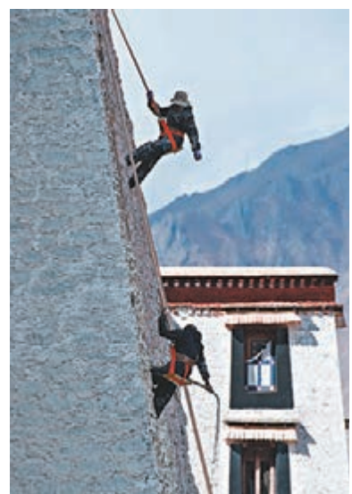
「蜘蛛俠」在宮殿高層飛檐走壁間向牆體灑灑調製好的灰漿。
