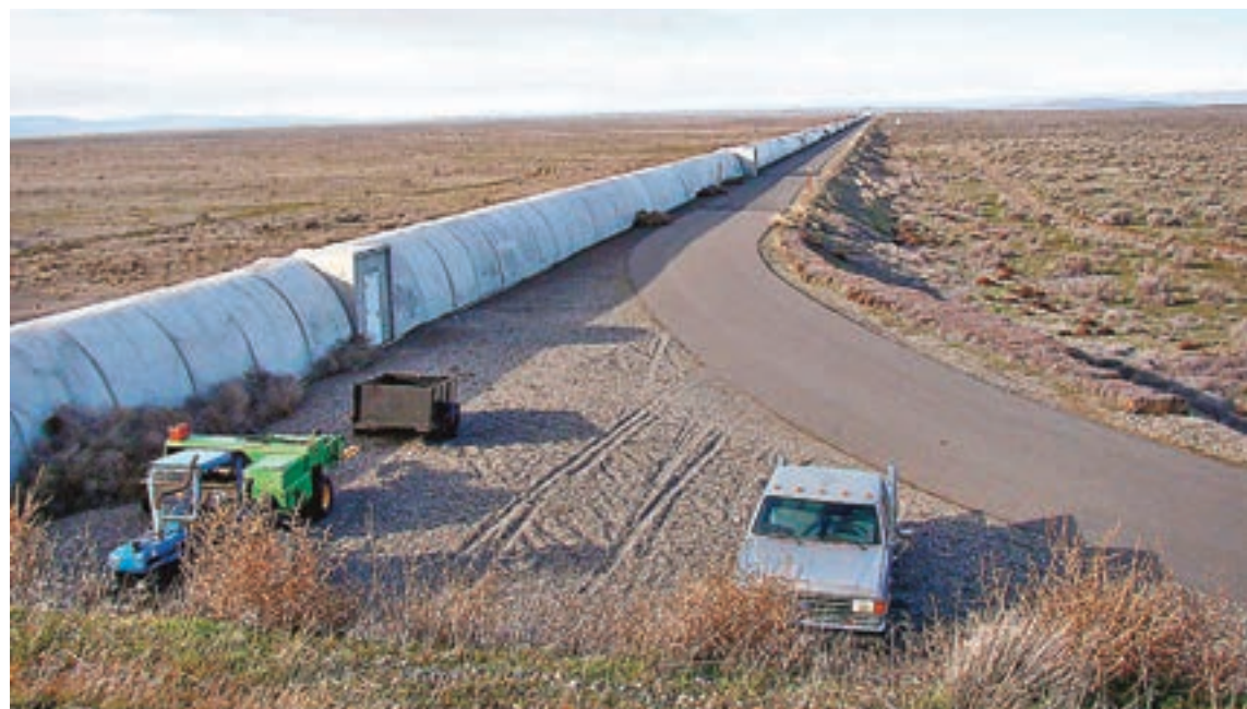
科學家們在重力波測量設備之外築起了隧道，再將內部空間的空氣抽走，造成接近真空的狀態。網上圖片
