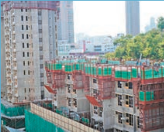
首置的房屋供應來自公營房屋以外的來源。圖為石硤尾在建中的公屋。
