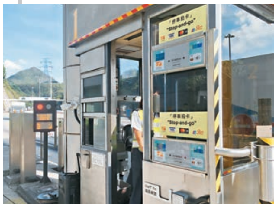
■ 城門隧道是首個提供「停車拍卡」式電子繳費設施的隧道。
