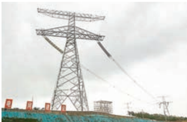
昌吉-古泉特高壓工程安徽段輸電線路。香港文匯報記者趙臣 攝
