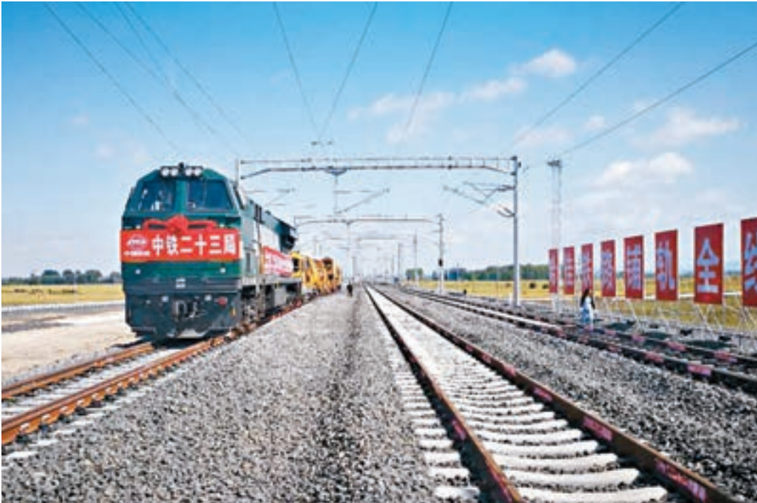
■內地最長的高寒地區快速鐵路——哈爾濱至佳木斯鐵路全線鋪軌完成。
