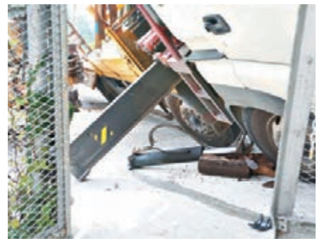
吊臂車伸出的支撐腳架折斷。
