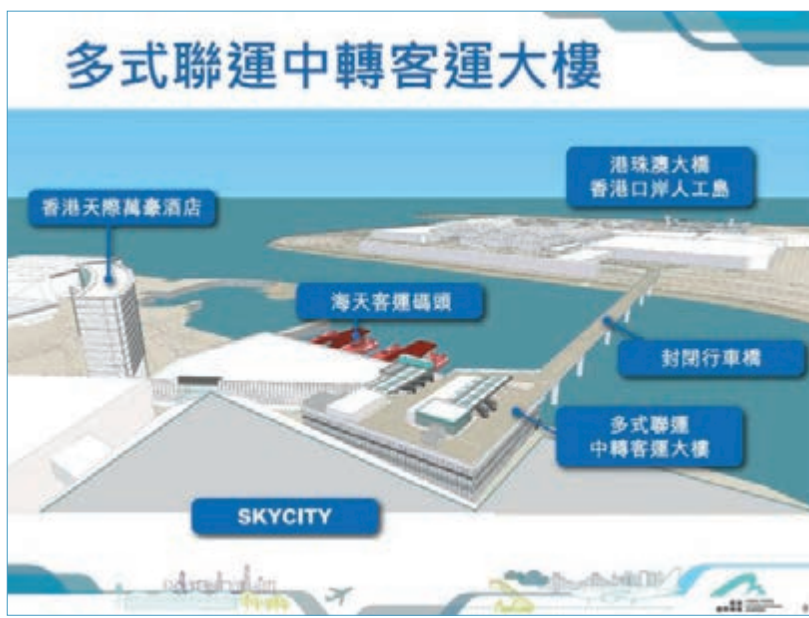
多式聯運中轉客運大樓位於現時機場海天客運碼頭南面,面積達2.2萬平方米,以一條長360米的封閉行車橋連接港珠澳大橋香港口岸。
