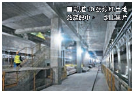
■軌道10號線紅土地站建設中。網上圖片
