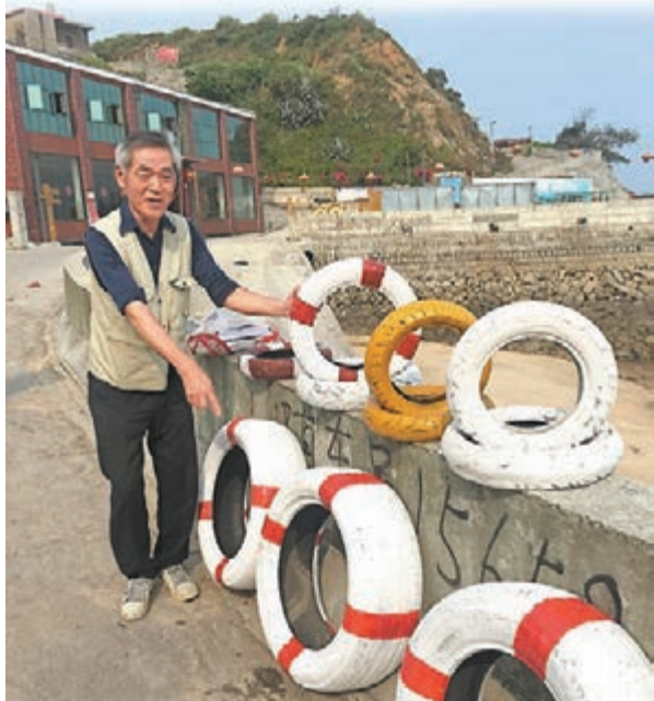
■梁長青在福建一漁村裡，用大卡車輪胎固定在堤壩邊上，既可做引導還可防撞，輪胎內還可種植各式花草作景觀，一舉多得。 受訪者供圖
