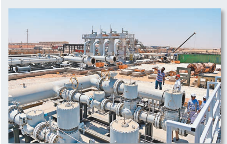
設備出口 中國石油技術開發公司為埃及最大發電站項目配套製造的天然氣調壓站近日運抵貝尼蘇韋夫項目現場進行安裝，這標誌著中國製造的此類設備首次進入埃及市場。文/圖：新華社
