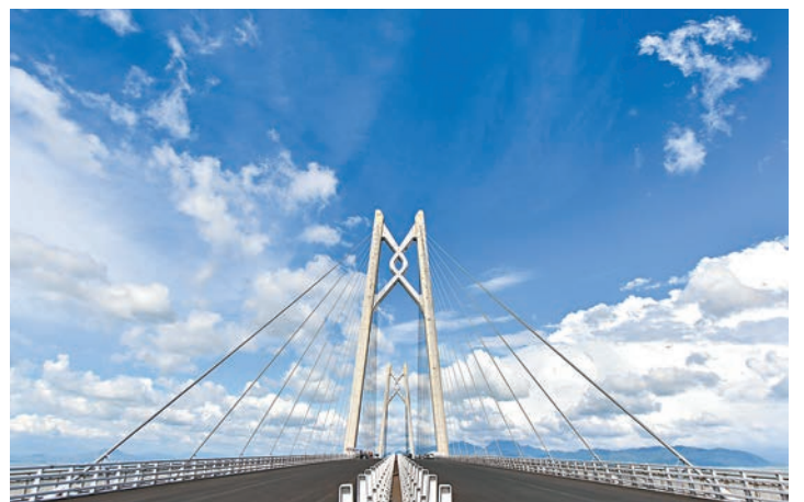
大橋3,000個結構關鍵位置,完成俗稱「打石屎槍」的非破壞性混凝土結構強度測試,並全部達標。 中新社
