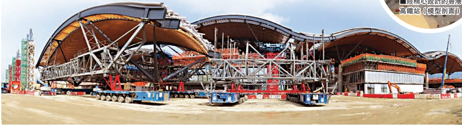
■旅檢大樓天幕預製元件安裝進行中，攝於今年4月
