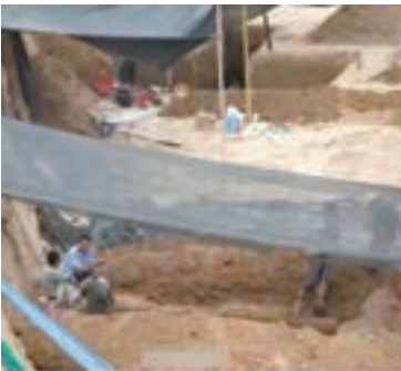
■西安建築科技大學華清學院校園內一建築工地挖出古墓。網上圖片
