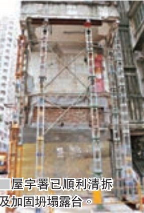
屋宇署已順利清拆及加固坍塌露台。
