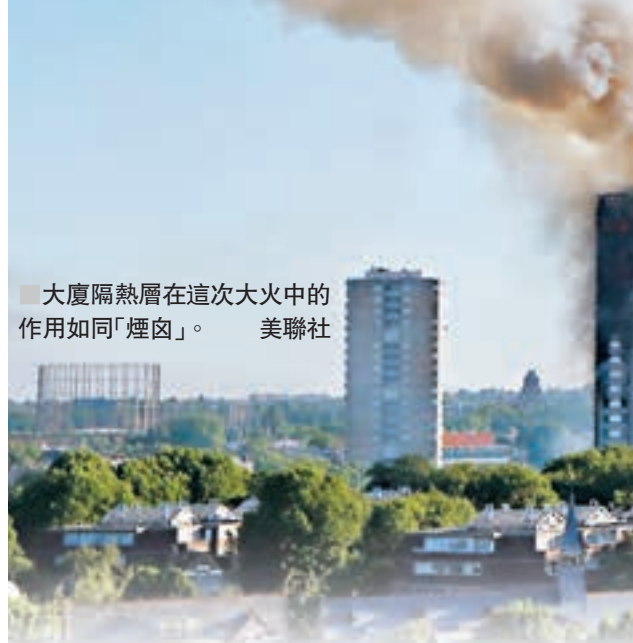
大廈隔熱層在這次大火中的作用如同「煙囪」。 美聯社
