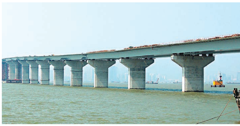
張炳良透露,當局已為港珠澳大橋工程2,049個關鍵位置打石屎槍檢測,全部符合要求。
