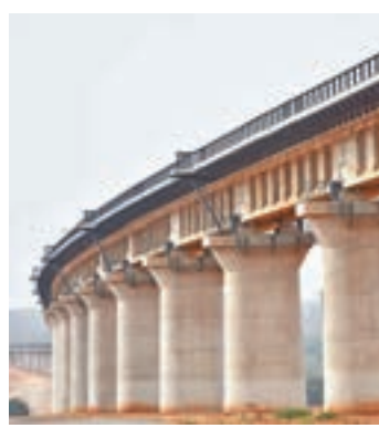
考慮到每年非洲都有大型動物遷徙，蒙內鐵路沿線特別設置了14處動物通道。 資料圖片
