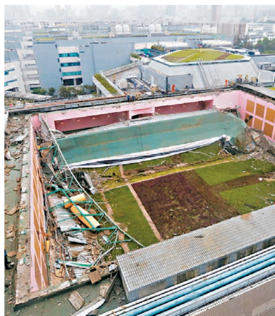
去年城市大學體育大樓環保綠化天台倒塌現場。資料圖片
