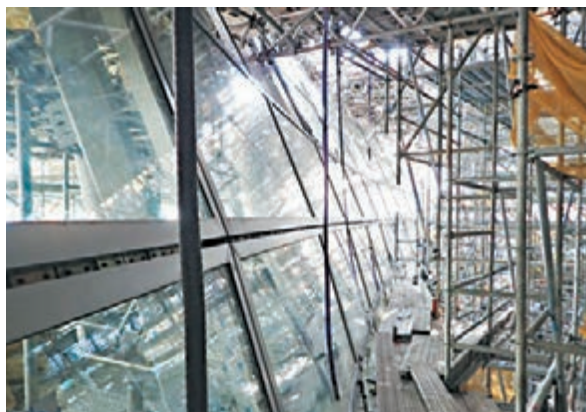
西九龍總站入口鋼結構南面的玻璃組件安裝工程。 港鐵公司供圖
