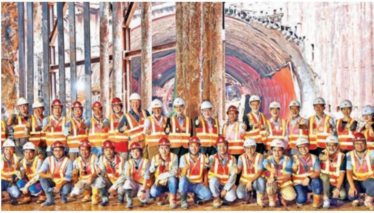
張炳良(後排右八)昨日在路政署署長鍾錦華(後排右九)陪同下,在港珠澳大橋香港接線觀景山隧道工地為工程團隊及前線人員打氣。
