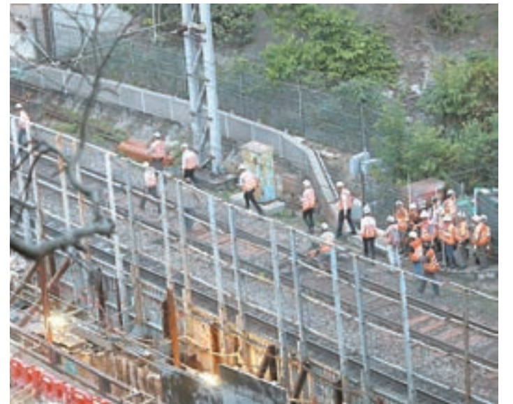
港鐵工程人員奔赴現場搶修電纜。
