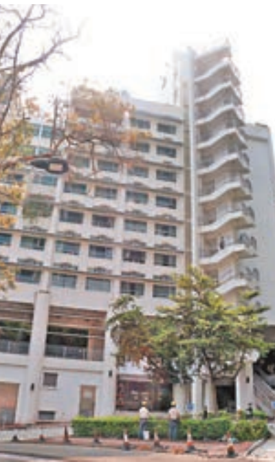
■陳震夏學生宿舍。2樓至6樓是女生宿舍，事發時「裸男」在3樓及4樓四處狂奔。
