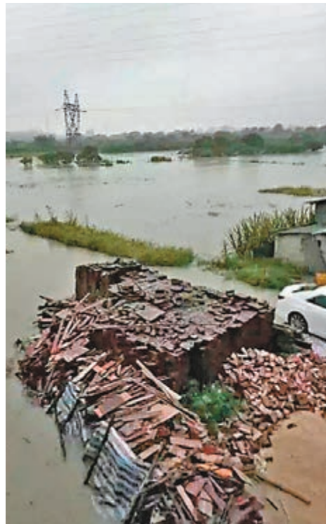
花都石角海橋因暴雨塌陷。 記者帥誠 攝
