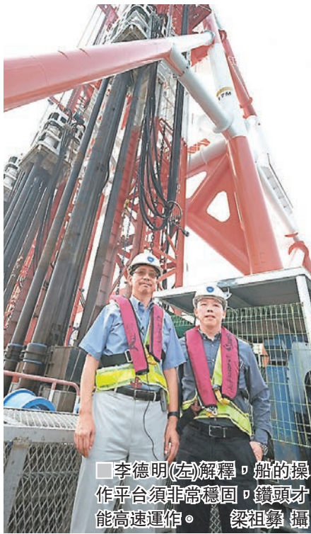
■填海工程使用的「深層水泥拌合法」，以20米至40米高的鑽頭，鑽入預設海床的深度，注入水泥及攪拌。梁祖彝攝
