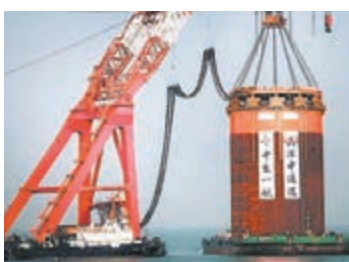
4,000噸起重船起吊鋼圓筒。中新社
