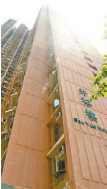
■揭發有住戶疑擲貓落樓的秀茂坪邨秀裕樓。
