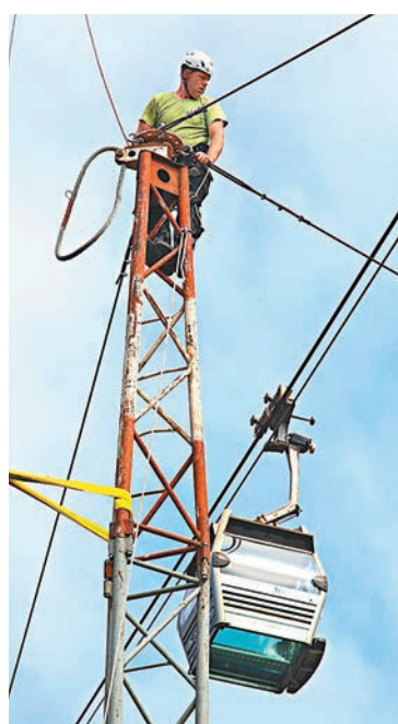
外國專家安裝臨時支架。昂坪360供圖
