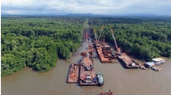
■工程機械龍頭企業——中聯重科履帶式起重機助力文萊跨海大橋建設
