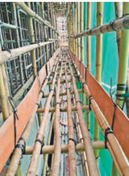
建造業議會要求外牆竹棚架必須於每層鋪設密竹或木板，以減少需要在竹棚架上工作者墮下的風險。
