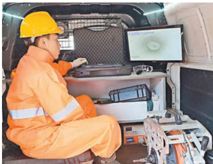
渠務署採用原位固化內襯修復技術，讓人員修復雨水渠時，毋須鑿開大幅路面。
