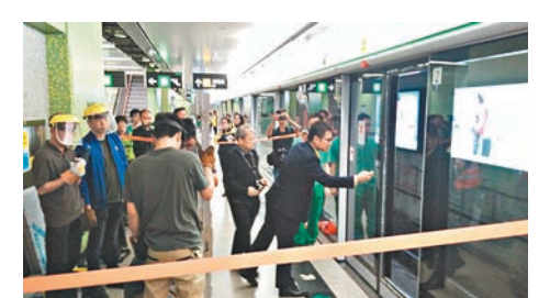
何文田站月台幕門爆裂，工程人員到場檢查。
