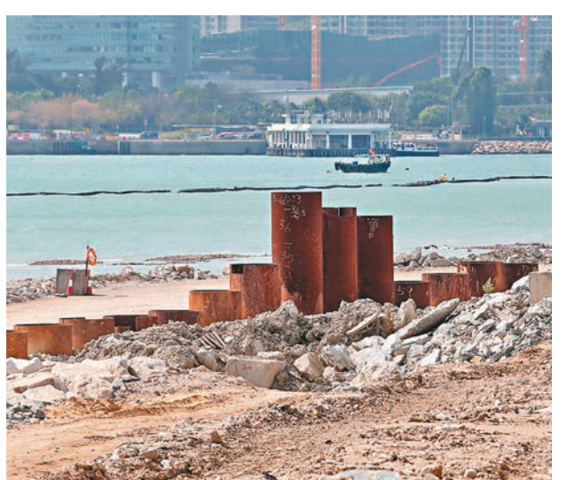
大橋工程處指填海鋼筒已達足夠深度。莫雪芝攝
