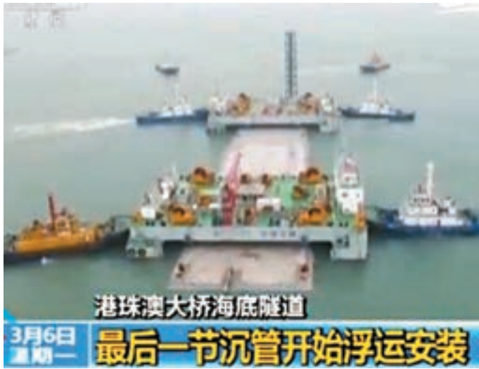
昨日，港珠澳大橋海底隧道最後沉管開始浮運安裝。
