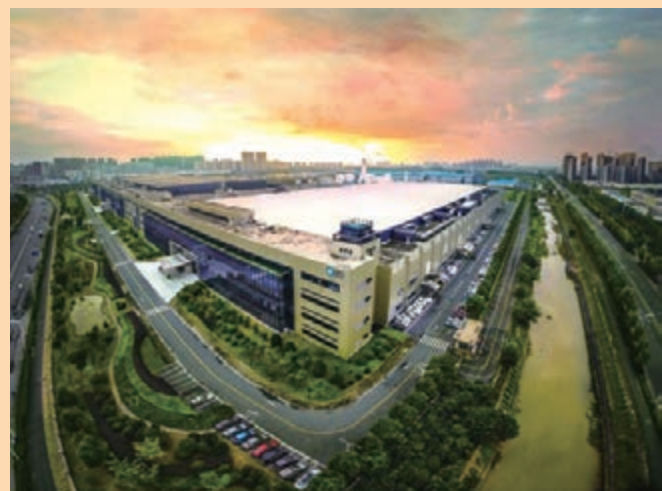
平板顯示是合肥國家綜合性科學中心建設重點發展的新興產業之一，合肥已建成全球最大規模的平板顯示產業基地，圖為京東方合肥生產廠房。
