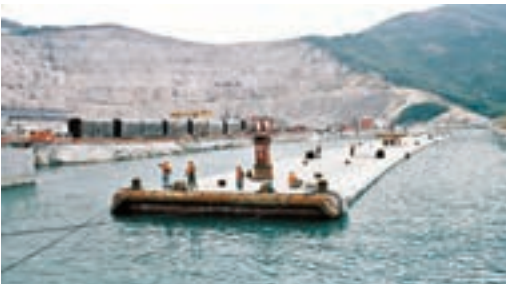
■1990年代機場鐵路工程，預製件浮運出工場。港鐵供圖
