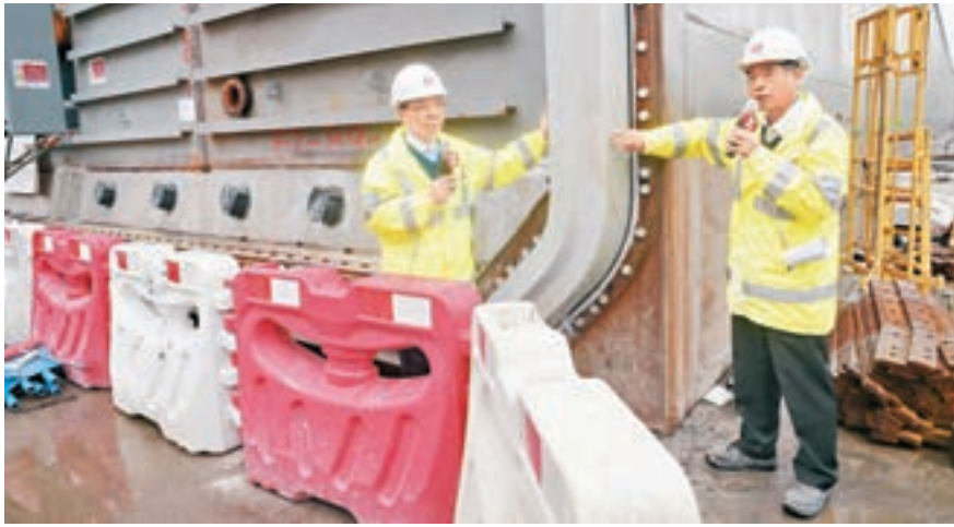
■沙中線過海隧道由11件每件高8米、長160米（約50層樓高）、重2.3萬噸的預製件組成。梁祖彝攝
