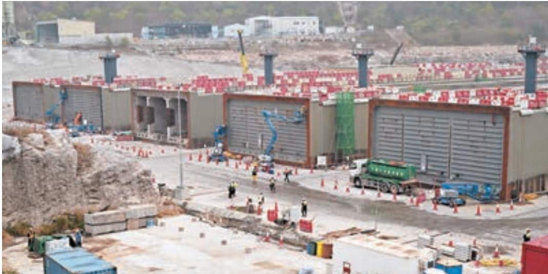
■沙中線過海隧道由11件每件高8米、長160米（約50層樓高）、重2.3萬噸的預製件組成。梁祖彝攝
