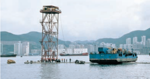
■1990年代機場鐵路工程，在預製件安裝測量塔及浮臺。港鐵供圖
