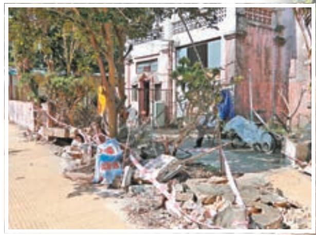
紅樓圍牆最近已被拆除。
