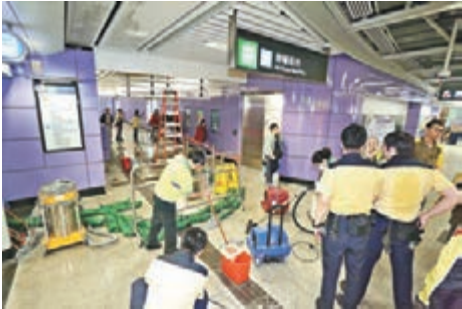
港鐵職員堆沙包圍封積水，出動地拖、吹風機等清理，僅留狹窄通道供乘客通過。
