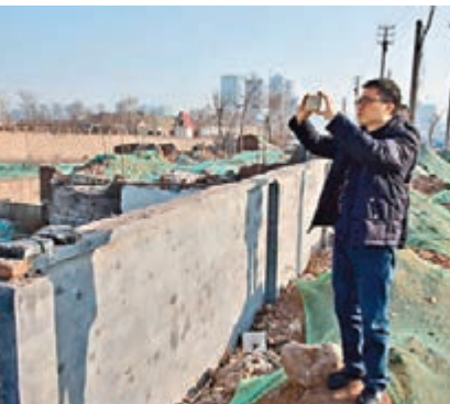
■環保部督查組昨日在山東濟南一工地檢查揚塵治理情況。 網上圖片
