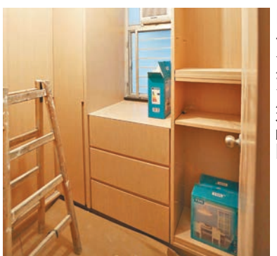
■工人房改更衣帽間。
