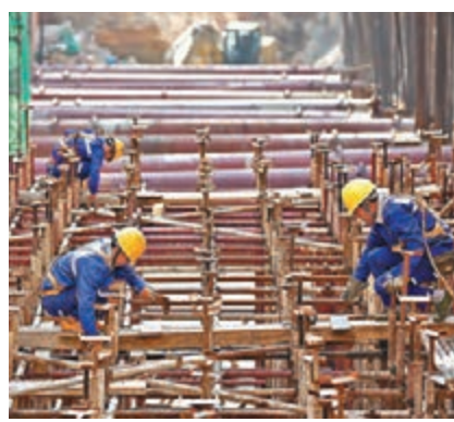
正在建設中的東部過境高速地下隧道。記者郭若溪攝
