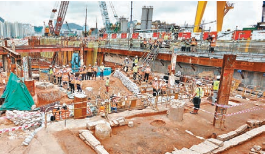
■成本管理辦事處檢視的項目包括港鐵沙中線部分工程。圖為沙中線工程地盤。 資料圖片
