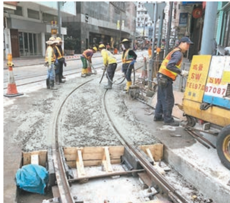
電車公司早前於堅尼地城爹核士街更換新路軌。 電車公司供圖
