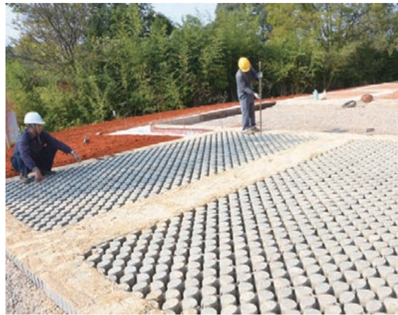
■工人正在鋪設透水磚
