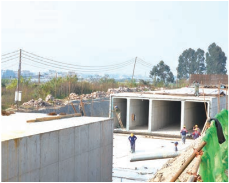
■玉溪海綿城市紅龍路項目正在緊張施工
