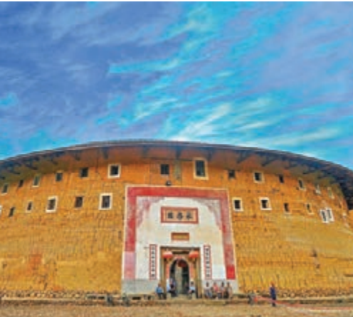
■福建永定高頭鄉承啟樓。
